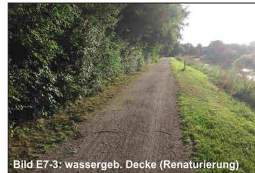
Bild E7-3: wassergeb. Decke (Renaturierung)
